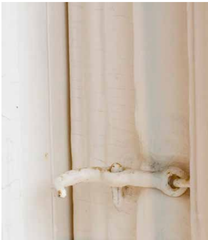
Detaljer opprinnelig vindu mot nord
