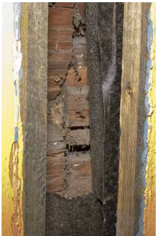
Tidligere vindu øst for bislag, sydveggen.
